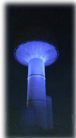
向日市 上植野浄水場
