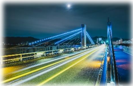
亀岡市 保津大橋
